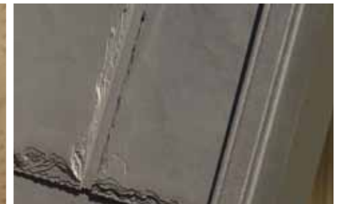
Finition double avec NoviTrim1 formant un coin intérieur sur 2 murs
