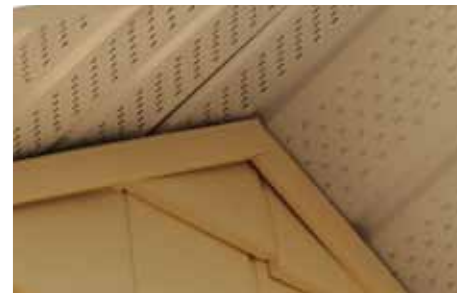
Finition avec NoviTrim1 pour coin extérieur et finition haut de mur
