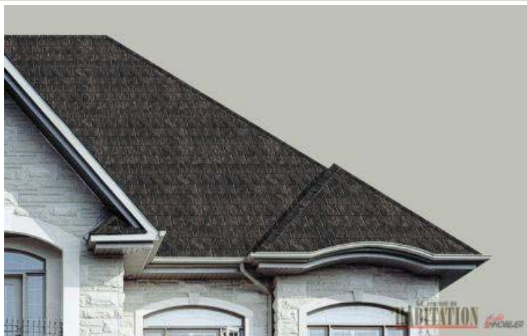
Un aperçu du résultat d'une toiture recouverte du revêtement à base de polymère mis au point par Novik.
